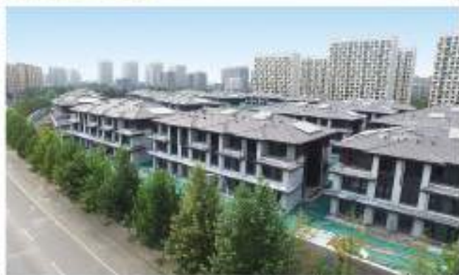
工程项目：北京·首城汇景墅 使用产品：W57-F1 无光深黑
