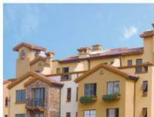
工程项目：厦门泉州·卢卡小镇 使用产品：A006 单彩 C5357 云彩
