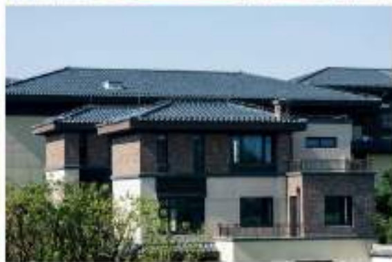
工程项目：扬州·玫瑰山庄 使用产品：WC63-R1 黛蓝
